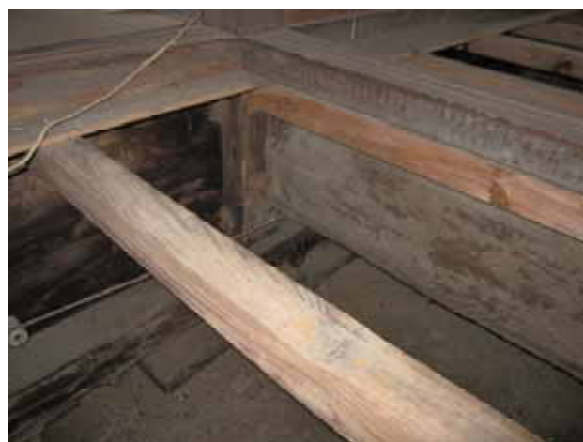
写真3 「地震の間」の柱脚部と足固め
