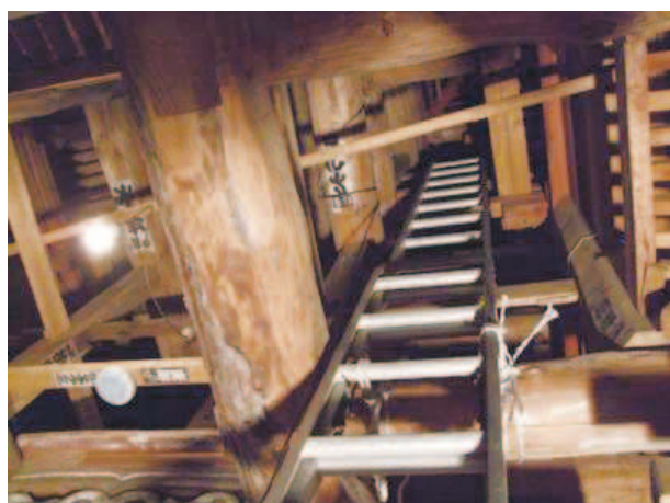
写真2 塔内部の様子（第1層から見上げたところ）
