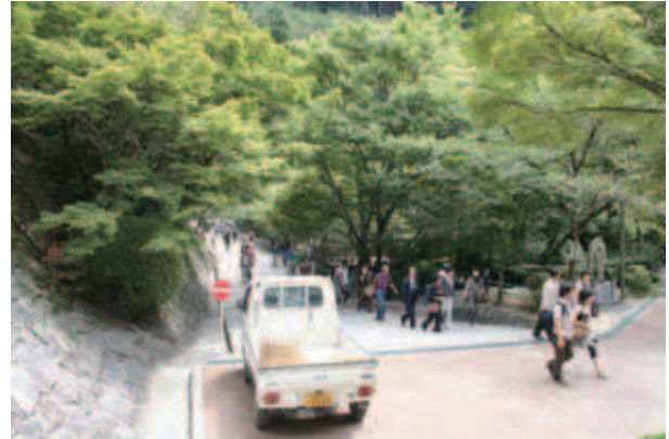
写真2 轟門下の石積み擁壁に接する参道
