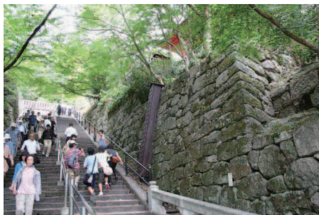
写真1 参道に接する石積み擁壁
