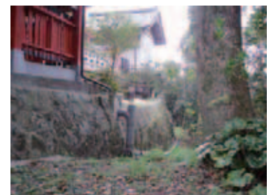
図6 地主神社背面側擁壁
