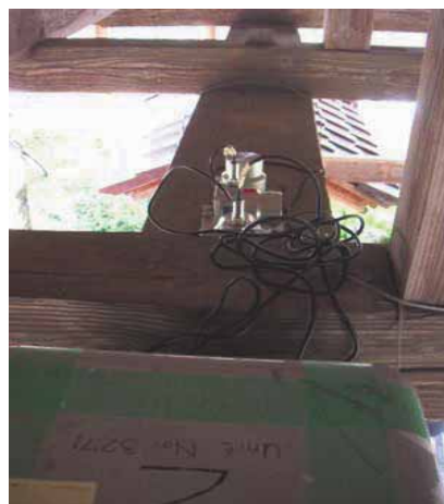
写真6 微動計の設置状況 <写真提供：三辻和弥氏(東北大)>
