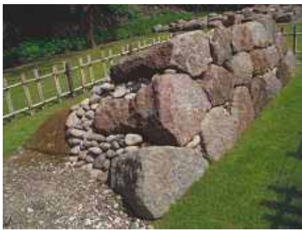
写真 1 打ち込みハギ積みの施工法
