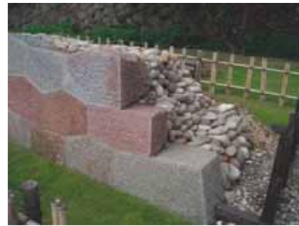
写真 2 切り込みハギ積みの施工法
