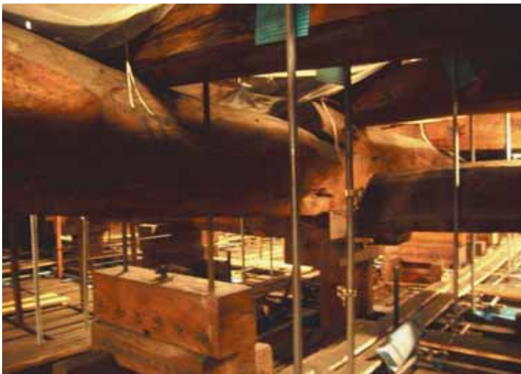
(a) 小屋組最下層の土居・牛引・小屋梁
