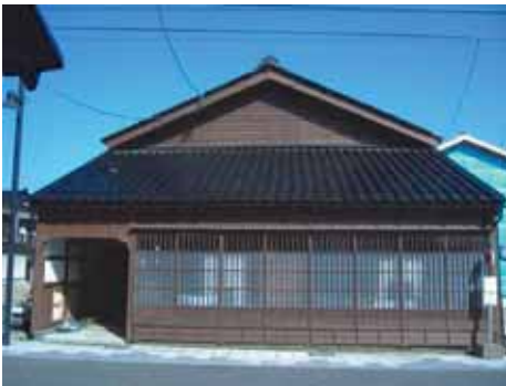
写真1 FK邸外観（西面）
