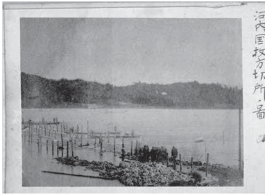
第8図 枚方伊加賀切所の粗朶工事の写真 (R1)
