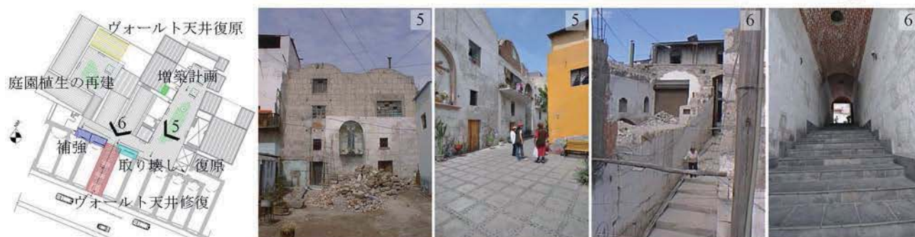
図4-6 市民施設文化遺産・ブロンセタンボ（2001年地震での通路ヴォールト天井の崩壊と修復）
