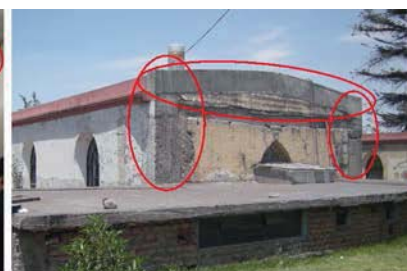
図3-4 病棟構造補強（RC構造）
