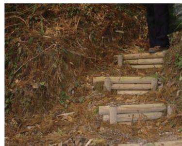
写真 5 急勾配散策道での雨水による階段の浸食の状況 (志布志城跡)
